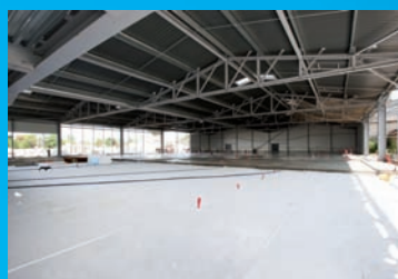
4 000 m 2 de Knauf Therm Dallage ép. 115 mm, Hypermarché Super U à Pont-du-Château, Entreprise Planche.
